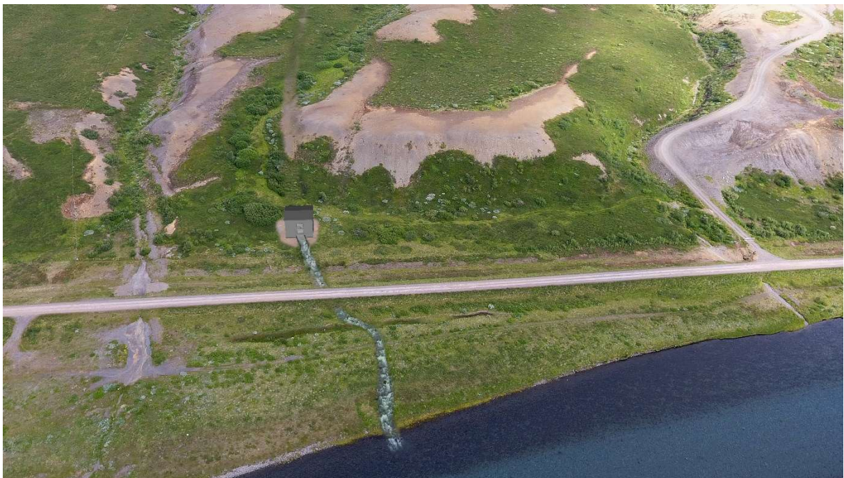
MYND 4.25 Séð yfir Fnjóskadalsveg eystri (nr. 835) og stöðvarhús eftir framkvæmdir. Aðrennslispipan er neðanjarðar en það sést móta fyrir raski eftir lagningu hennar. Á myndina vantar veltenginu við húsið en veltenging og gatnamót verða hönnuð í samráði við Vegagerðina. Frárennisskurður fer í ræsi undir veg nr. 835.
