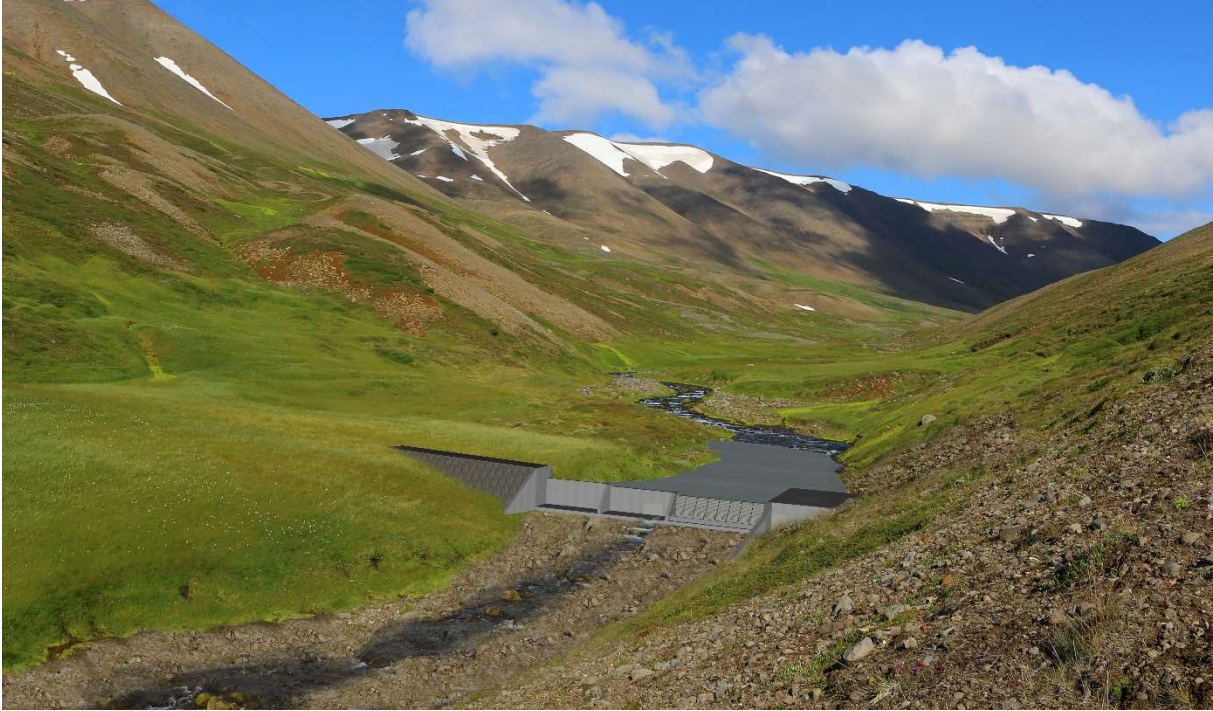
MYND 2.6 Líkanmynd af stíflustæði í Gönguskarði með lóni í yfirfallshæð sýnt á ljósmynd.
