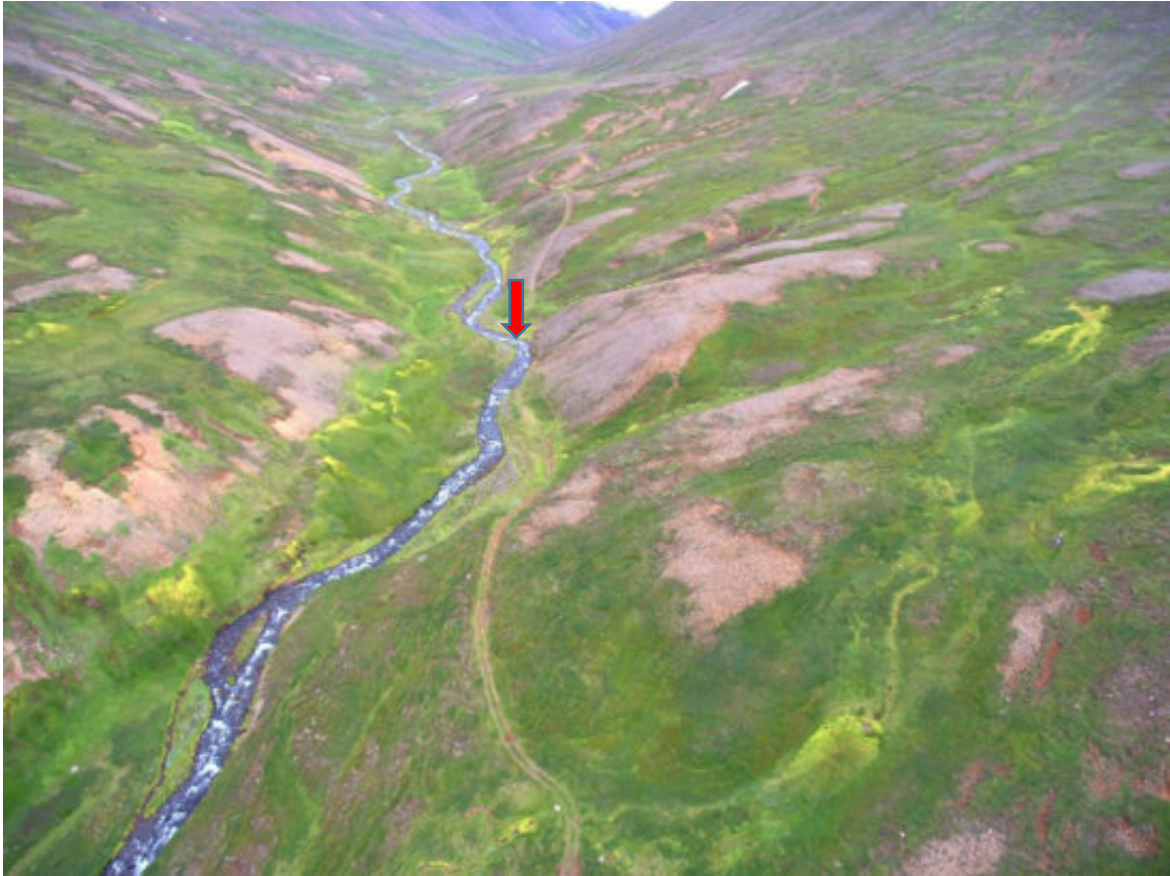
24. mynd. Horft til austurs inn í Gønguskarð. Fyrsti hluti aðrennslispípu frá stíflu í Gønguskarði liggur samhliða vegi í gömlum vegslóða sunnan Gønguskarðsár. Stíflustæði merkt með rauðri ör.
