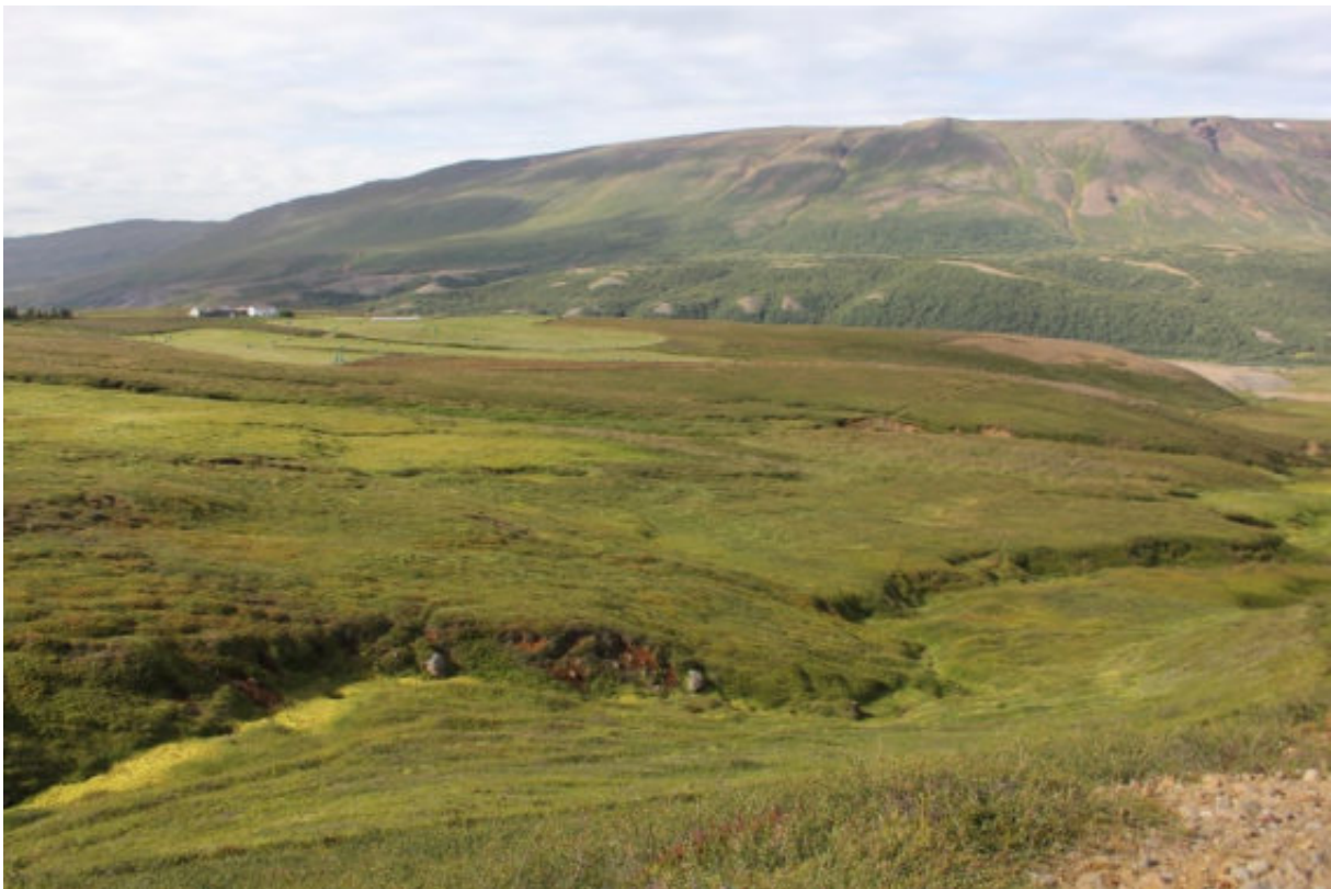
17. mynd. Leið þrýstipípu og vegar upp hlíðar Fnjóskadals, skammt norðan við bæinn Ytri-Hól. Vegur og þrýstipípa koma saman hægra megin við túnið sem sést á myndinni.
