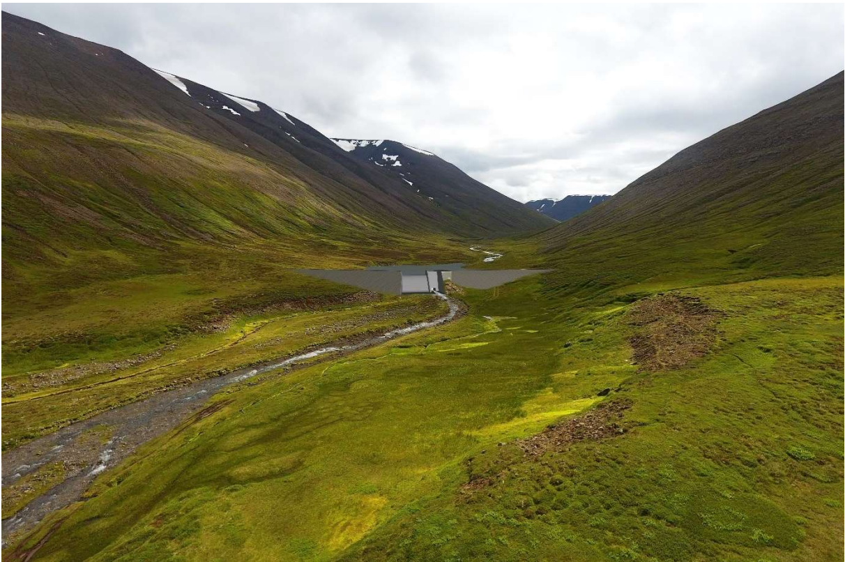
MYND 4.27 Séð inn Hólsdal að sumarlagi eftir framkvæmdir. Á myndinni má sjá fyrirhugaða stíflu og inntakslón í yfirfallshæð. Á myndina vantar vegslóð að stíflu. Nærmynd af stíflu má sjá á mynd 2.4.
